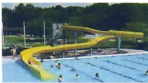
Sanierung Freibad Reichelsheim
